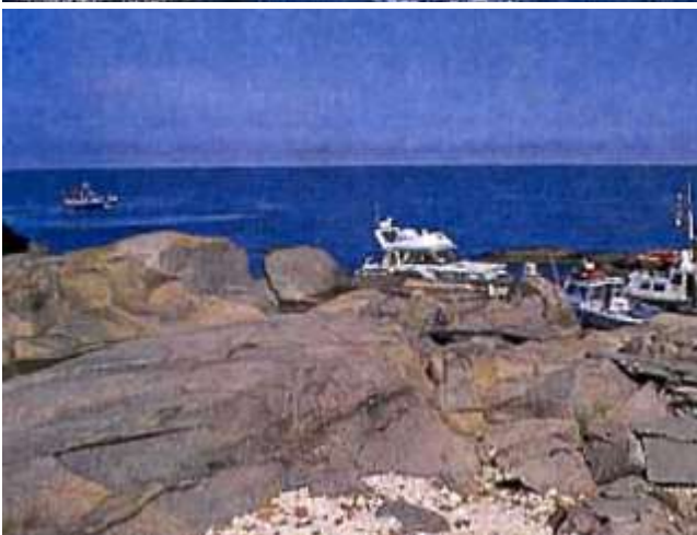
Bengtskär on karu ulkoluoto. Mahtavan majakkarakennuksen metriset seinät on verhottu saaresta louhitulla graniitilla.
